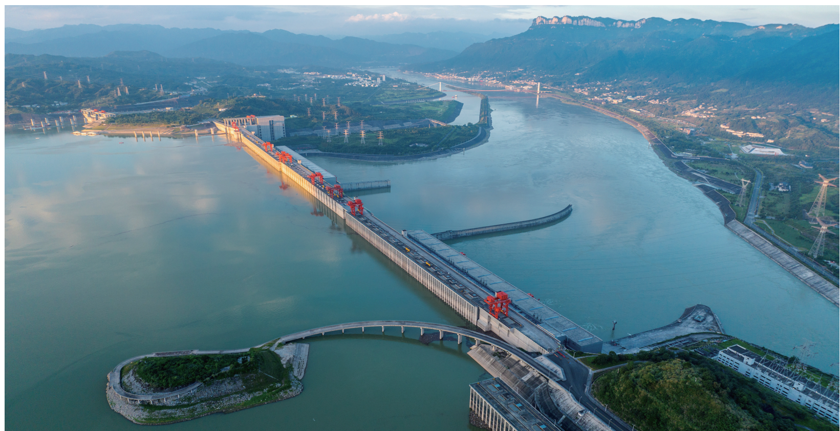
2023年7月10日,三峡电站首台机组投产发电整20年,20年来,三峡电站已累计发出16000多亿千瓦时清洁电能。三峡电站共安装34台水轮发电机组,总装机容量2250万千瓦,年设计发电量882亿千瓦时,是我国“西电东送”和“南北互供”的骨干电源点,电能昼夜不息被送往华东、华中、广东等地。这是7月9日在湖北省宜昌市拍摄的夕阳映照下的三峡水利枢纽工程(无人照照片)。
