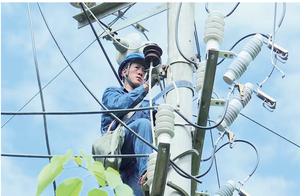
国网略阳县供电公司电力工人在兴州街道安林沟村山岭间进行过负荷配变更换作业。 许洋 摄
