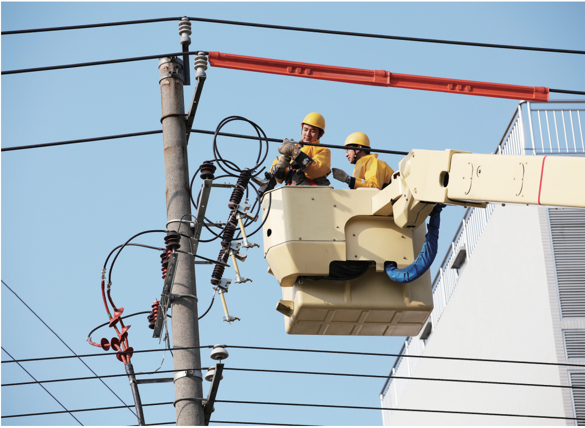
7月18日下午2点多，电力工人身着密不透气的绝缘工作服，在烈日下进行带电作业。
