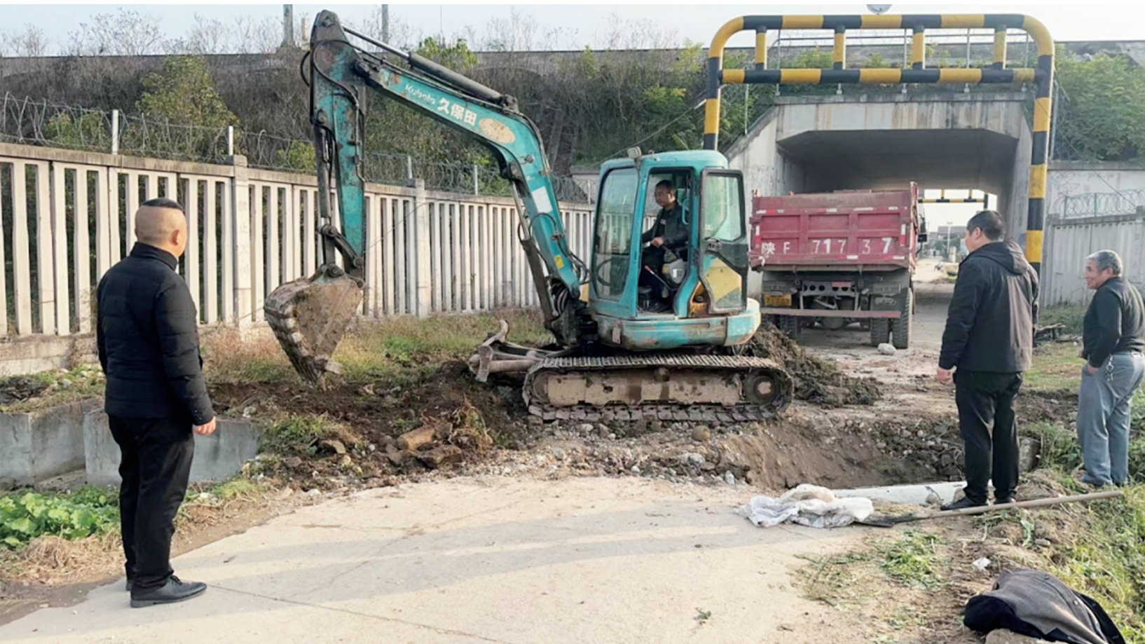
近日，城固县莲花街道办事处五里庙村进行道路修缮。该村干部在道路安全巡查走访过程中了解到，村内通往城许公路高铁涵洞出入口路面破损、凹凸不平，存在交通安全隐患。对此，村“两委”及时召开道路修缮工作协调会议，研究解决修缮资金等问题，并结合实际形成具体施工方案。在多方配合下，加快施工，完成了坑洼道路修缮，极大地方便了群众出行。
