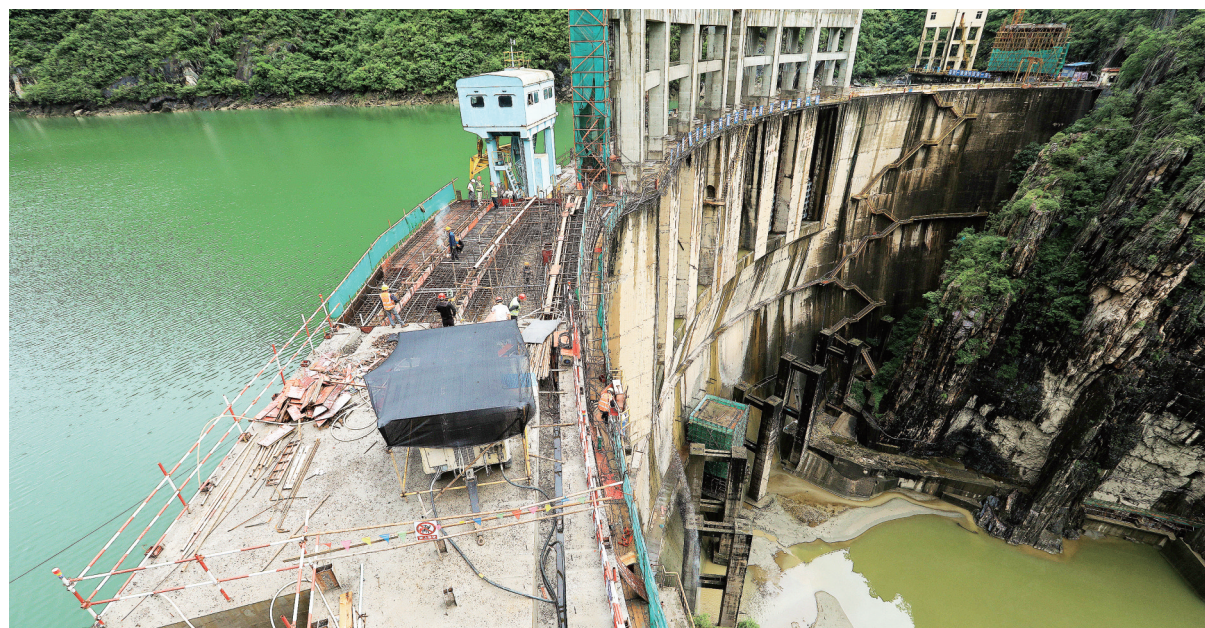
石门除险加固工程现场。
