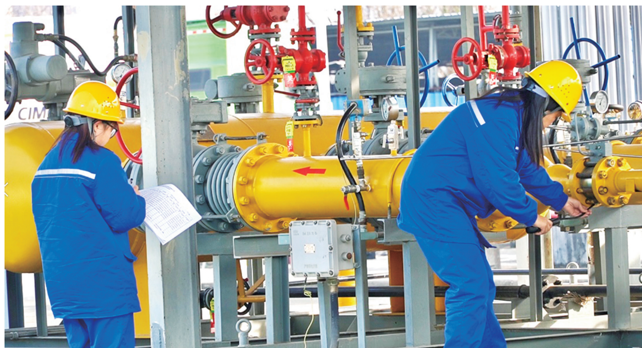
连日来，陕西津滨新能源投资发展有限公司组织管道维保工人全面摸排维护天然气管线，确保天然气正常供应、群众温暖过冬。据了解，目前，市中心城区天然气日供气量已突破80万立方米。
