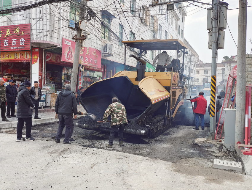
去年以来,洋县不断改善城市基础设施建设,提升居民幸福指数。图为育才路部分路面正在改造。 张松民 摄
