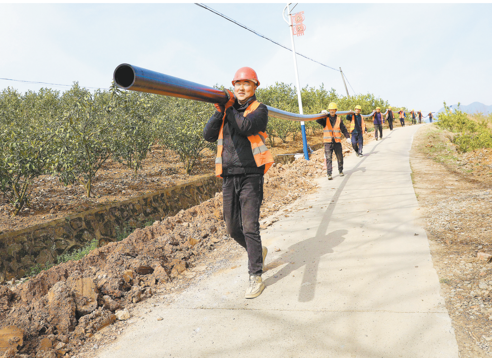
汉台区持续推进城乡供水一体化建设，助力乡村振兴。图为施工人员在汉王镇永久村铺设供水管道。
