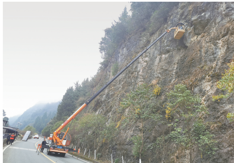
3月14日，镇巴公路段对210国道2处高边坡路段浮石进行清理。魏涛 摄
